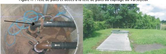
Figure 17 : Tête de puits et accès à la tête de puits du captage du Val Joyeux
